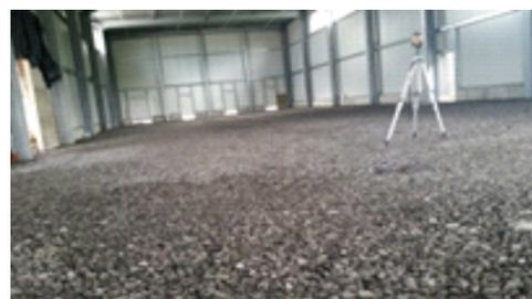
Eine aufwändige Arbeit, aber nach 12 Stunden war das Ende in Sicht und nach dem abschließenden Einebnen konnte mit dem Verdichten begonnen werden.
